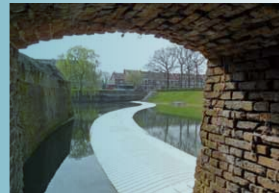
Houten waterbrug Ravelijn (verdedigingsbolwerk), gerealiseerd in 2014.
